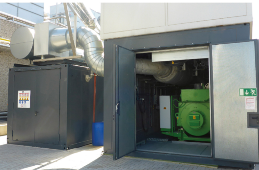
Betreibern von KWK-Anlagen und Blockheizkraftwerken droht eine rückwirkende Nachzahlung erhaltener Eigenstromprivilegien nach EEG, wenn sie den selbstproduzierten und eigenverbrauchten Strom nicht von Stromlieferungen an Dritte abgegrenzt und an den zuständigen Übertragungsnetzbetreiber gemeldet haben. Bild: Energie-Admin
